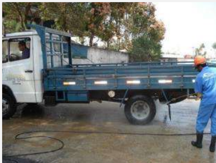
Ex: implantação de lava-rodas no canteiro
