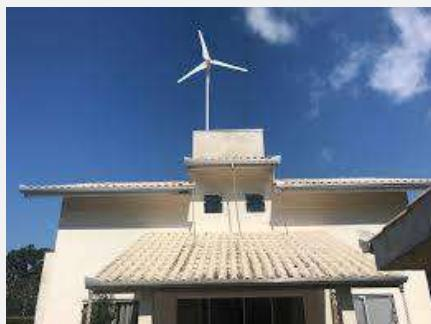
É a energia produzida a partir da força dos ventos e é gerada por meio de aerogeradores de pequeno porte. A velocidade do vento aumenta com a altura e depende do que está construído nos arredores. Deve-se analisar a existência de obstáculos que possam influenciar o comportamento dos ventos.
