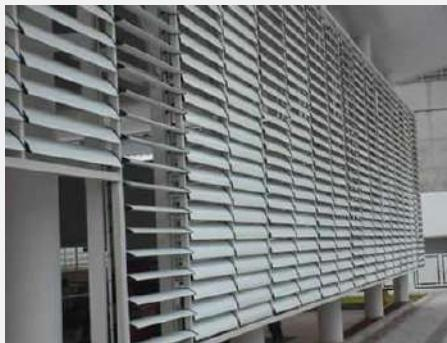
Os brises barram a incidência da radiação solar antes que ela atinja a fachada e, consequentemente, o ambiente interno, reduzindo o calor recebido. Também controlam a incidência de luz e garantem conforto térmico à edificação.
